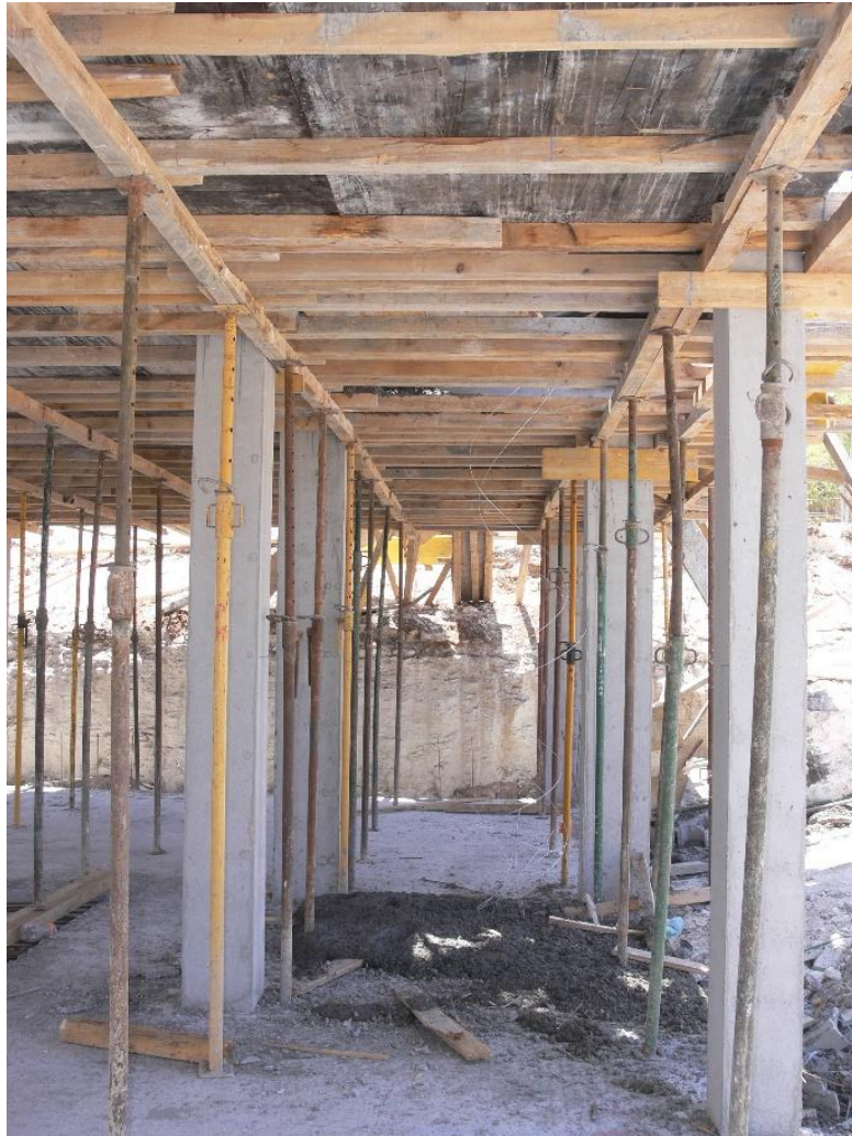
Fotografía 3. Encofrado horizontal aligerado con bovedilla del primer forjado, con una altura estándar de 2,80 m. (INVASSAT)
