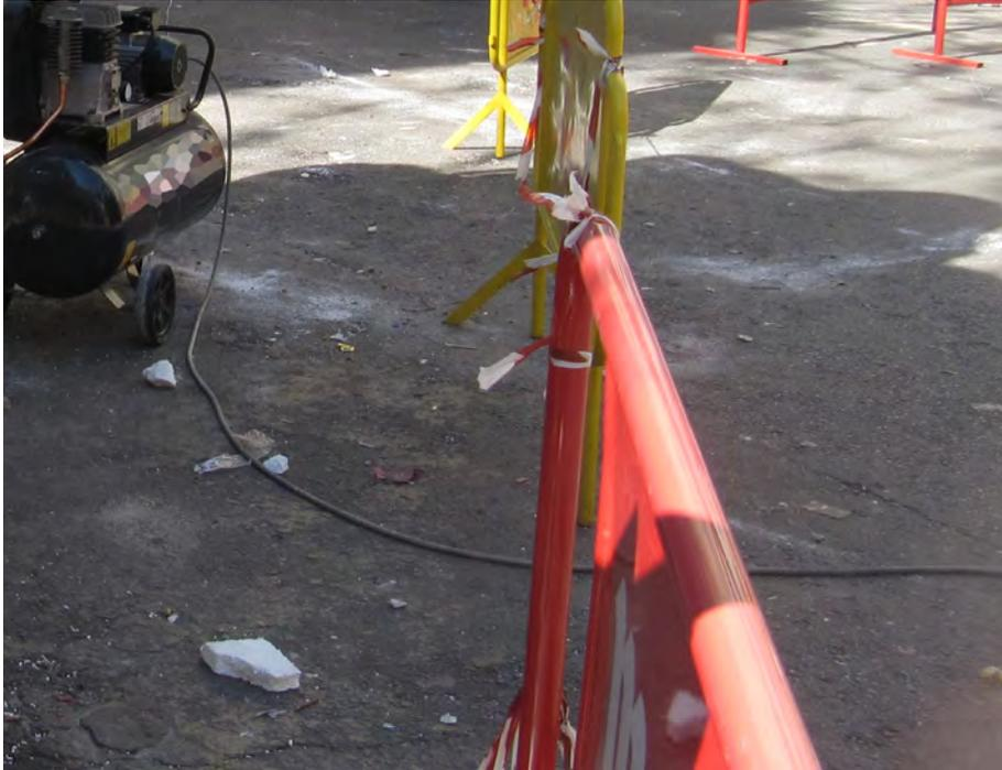
*Ejemplo de manguera de conductores de alimentación del compresor tendido por el suelo sin ningún tipo de protección mecánica. INVASSAT*
