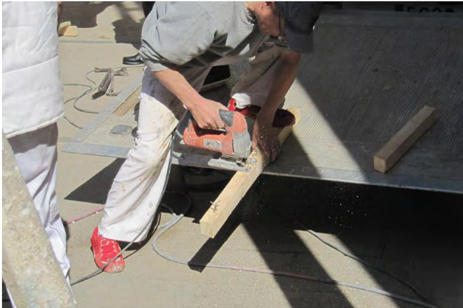
*Operaciones de corte de madera mediante sierra de calar (arriba) y montaje de un pendiente mediante pistola clavadora (debajo), realizadas en la "plantá". INVASSAT*
