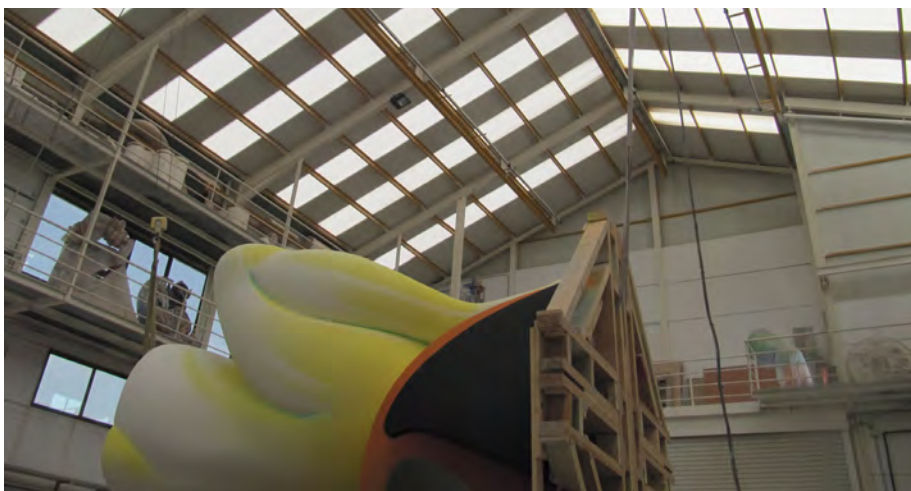
Ejemplo de carga utilizando dos puentes grúa monocarril. INVASSAT
