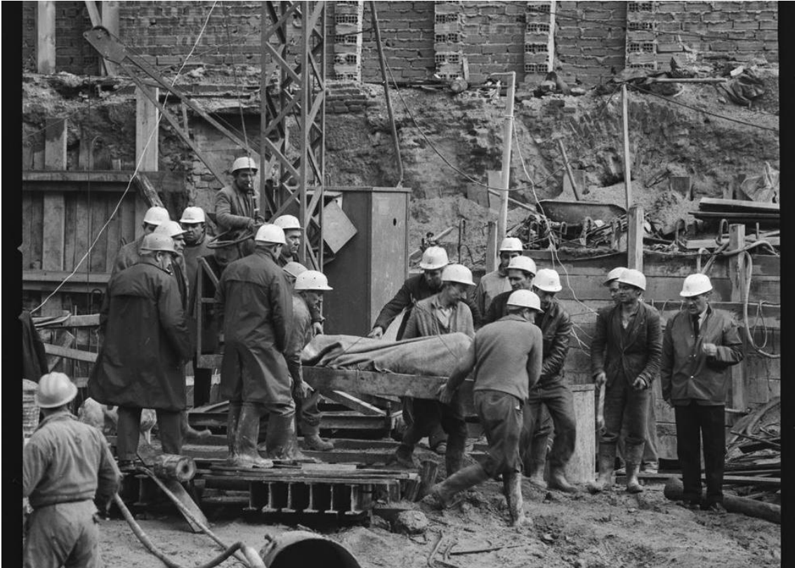
Pando Barrero, Juan Miguel. Obra nuevas Galerías [Solar en construcción, posiblemente para un Galerías Preciados en la plaza del Callao, donde un grupo de trabajadores parece llevar un cadáver cubierto] . 1965. Fototeca del Instituto del Patrimonio Cultural de España .
