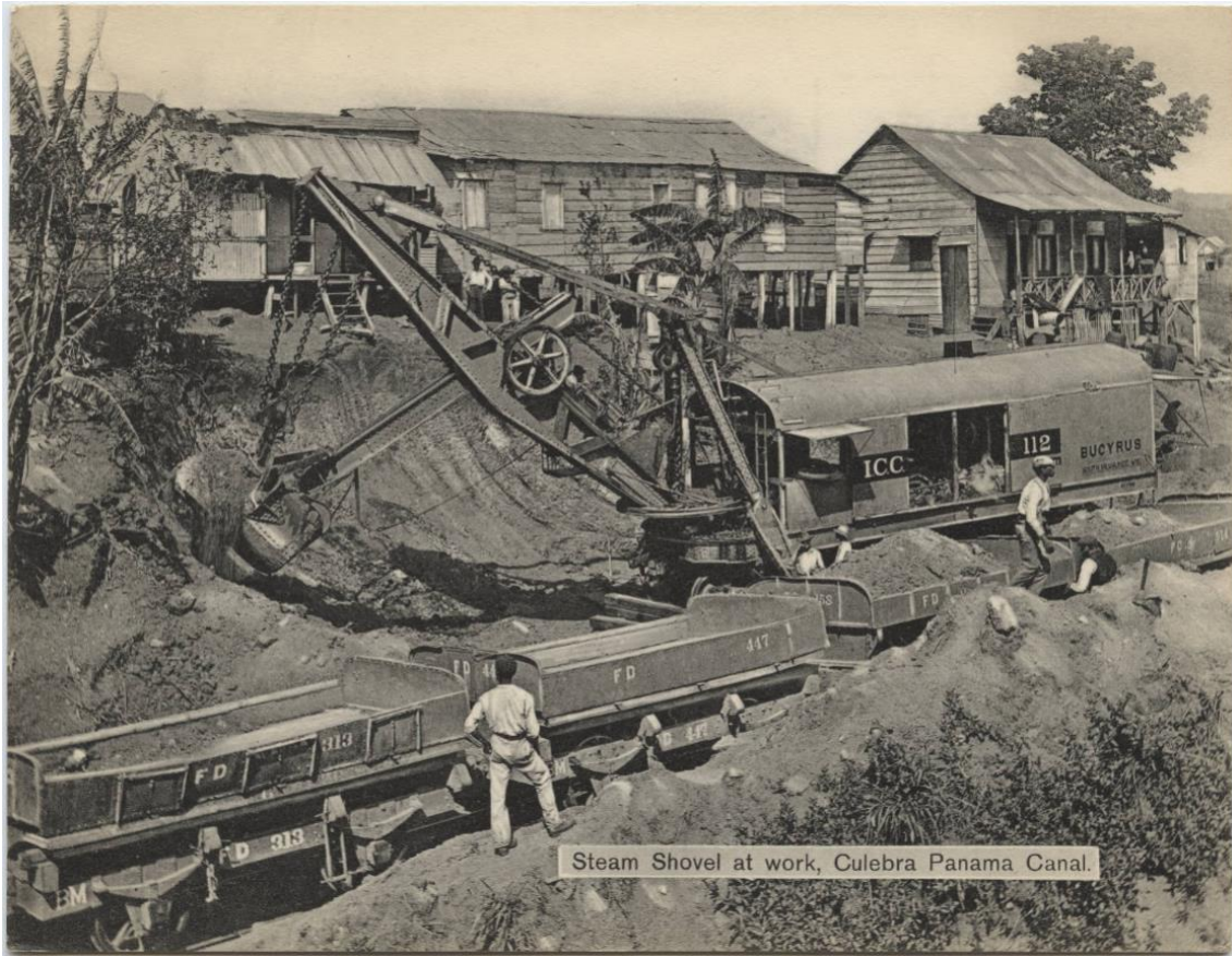
I. L. Maduro, jr. Steam shovel at work . 1900-1909. SMU Central University Libraries . Document sense restriccions conegudes de drets d'autor.
