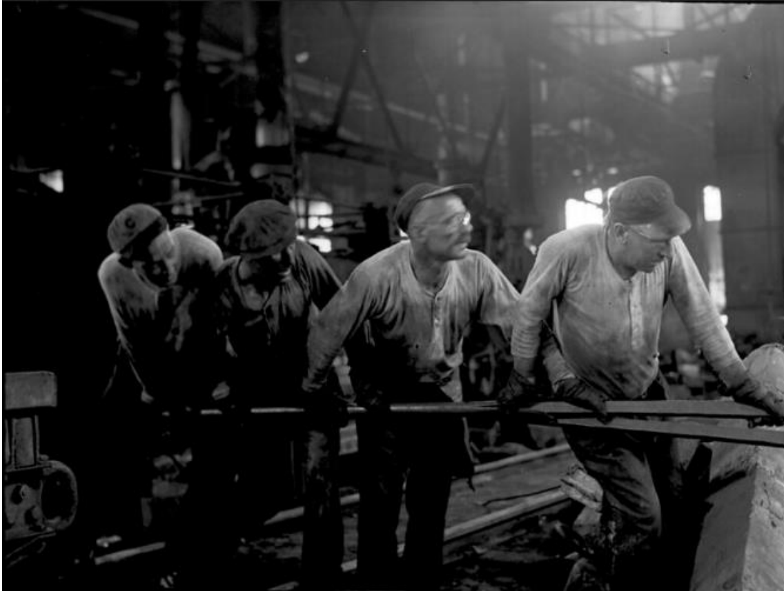
John Mudd. Four Midvale Company employees working tongs in Smith Shop, August 1932. 1932. The Kheel Center for Labor-Management Documentation and Archives , via Flickr . Document compartit amb llicència Creative Commons CC BY 2.0 .
