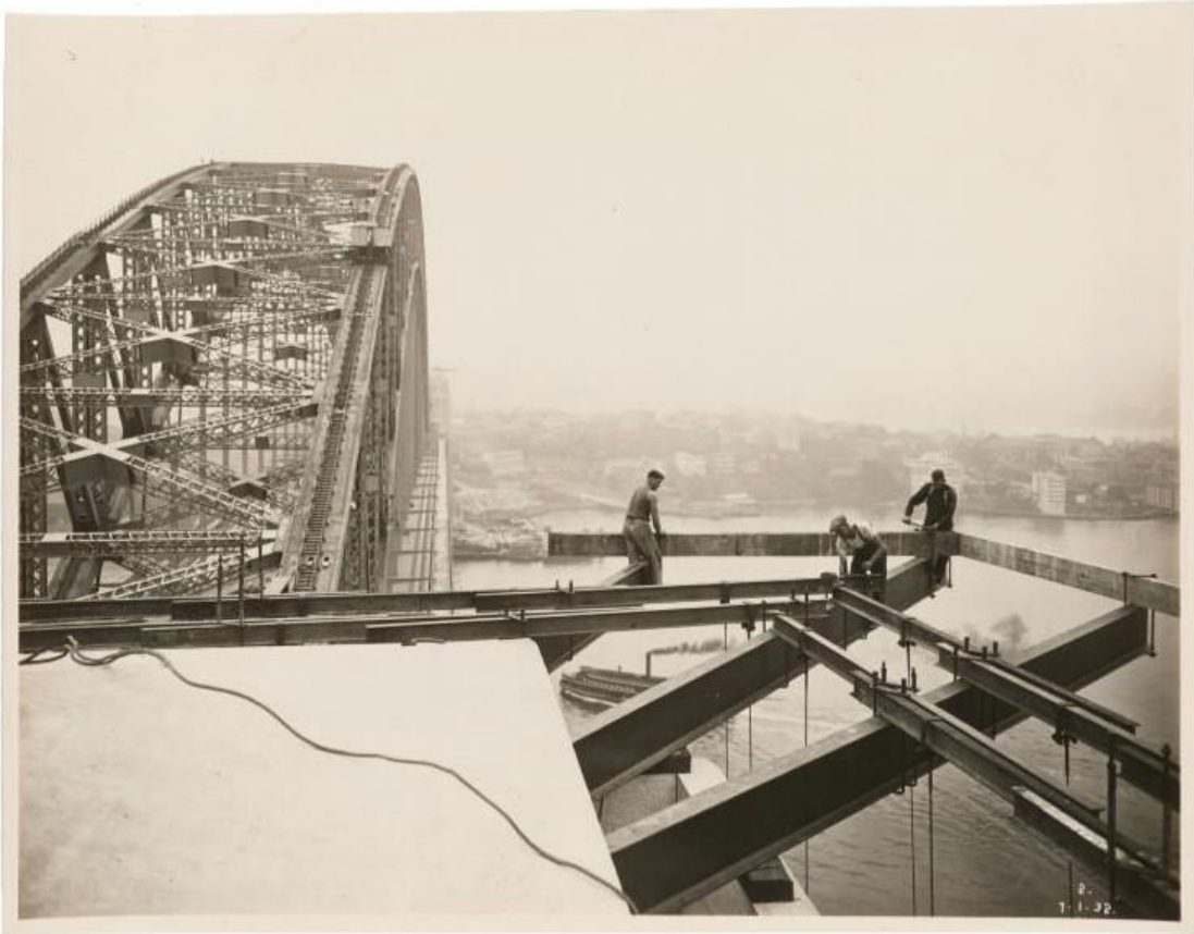
Workmen attaching the supports to a pylon of the Sydney Harbour Bridge. 1932. Museum of Applied Arts & Sciences . Document compartit amb llicència Creative Commons CC BY-NC-ND 4.0 .
