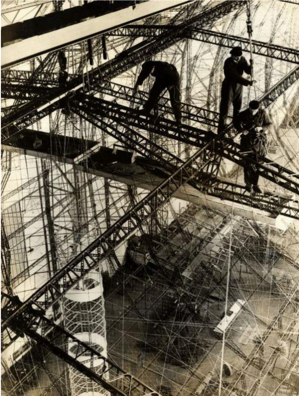
Arbeiders aan het werk in zeppelin-fabriek = Workers of the Zeppelin factory. 1934. Nationaal Archief , via Flickr . Document sense restriccions conegudes de drets d'autor.
