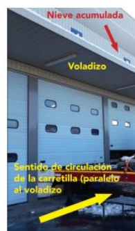
Figura 1: Voladizo y descripción del recorrido de la carretilla
