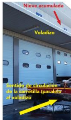
Figura 1: Voladizo y descripción del recorrido de la carretilla
