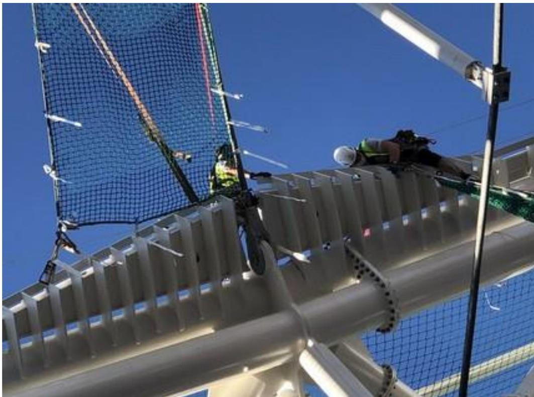
Fotografía 11. Detalle de la sujeción de la red de seguridad a partes de la estructura del anillo y del cable de acero mediante bandas textiles y trasteles
