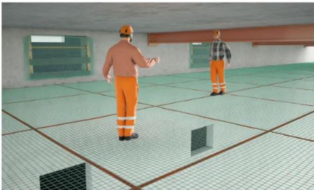
Ilustración 1. Red de seguridad instalada como plataforma de trabajo (DEUTSCHE GESETZLICHE UNFALLVERSICHERUNG, 2021, pág. 8)
