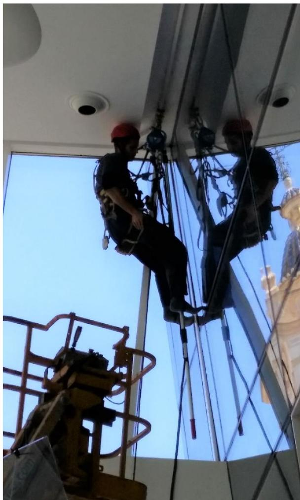
Fotografía 1. Operario realizando trabajos verticales
