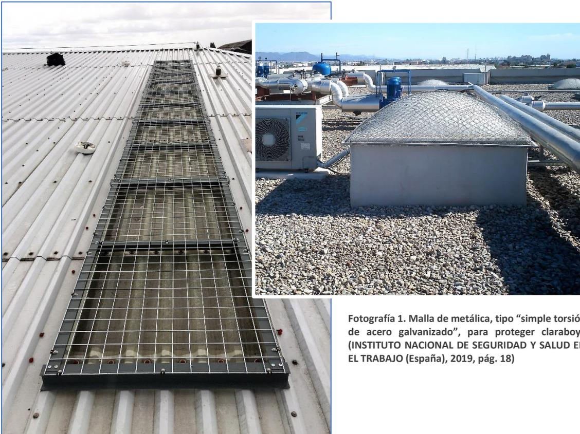
Fotografía 1. Malla de metálica, tipo “simple torsión de acero galvanizado”, para proteger claraboya (INSTITUTO NACIONAL DE SEGURIDAD Y SALUD EN EL TRABAJO (España), 2019, pág. 18)
