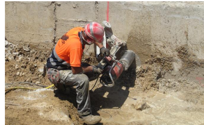
TRABAJO EN VÍA HÚMEDA
