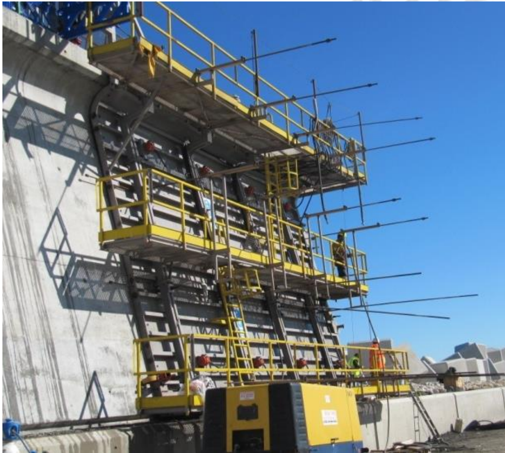
USO DE VIBRADORES MANUALES (VMB) SOBRE CARRO DE ENCOFRADO (PLATAFORMA VIBRANTE - VCE)
