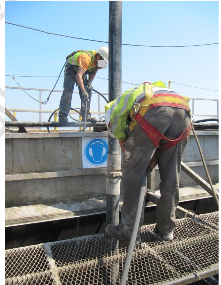
USO DE VIBRADORES MANUALES (VMB) SOBRE CARRO DE ENCOFRADO (PLATAFORMA VIBRANTE - VCE)
