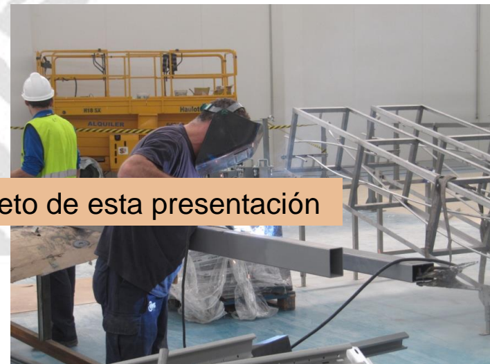
HUMOS METÁLICOS (SOLDADURA ELÉCTRICA AL ARCO)
