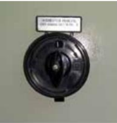
Figura 2. Interruptor seccionador.
