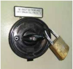
Figura 6. Bloqueo de un seccionador mediante candado.
