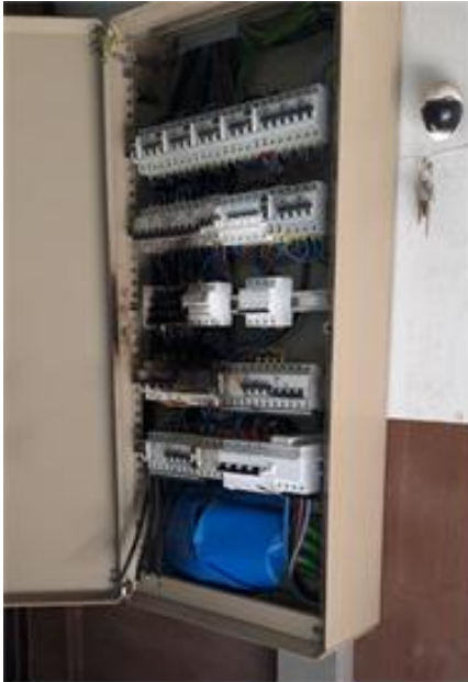
Fotografia 2. Quadre sense proteccions
