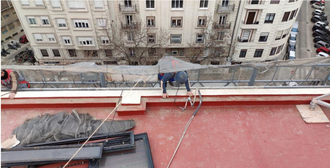
Fotografía 3. Ejemplo de un trabajador saliendo de la plataforma de un andamio colgado subiéndose a los elementos que componen la barandilla del mismo, a modo de escalera, y desembarcando en la cubierta del edificio sobre el que se estaba trabajando. INVASSAT.
