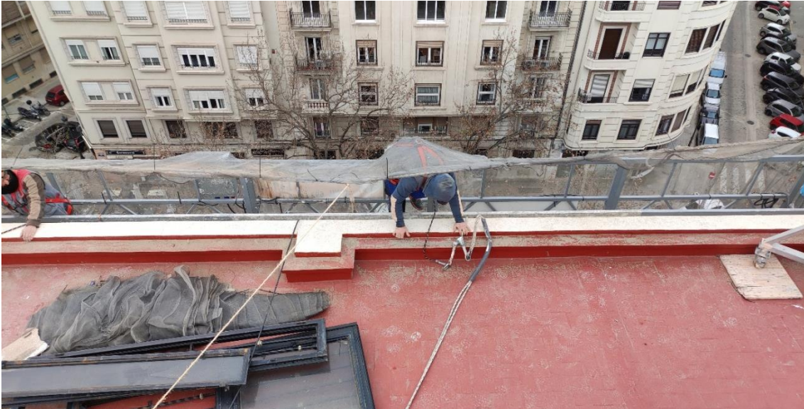
Fotografia 3. Exemple d'un treballador eixint de la plataforma d'una bastida penjada pujant-se als elements que componen la barana d'aquest, a manera d'escala, i desembarcant en la coberta de l'edifici sobre el qual s'estava treballant. INVASSAT.
