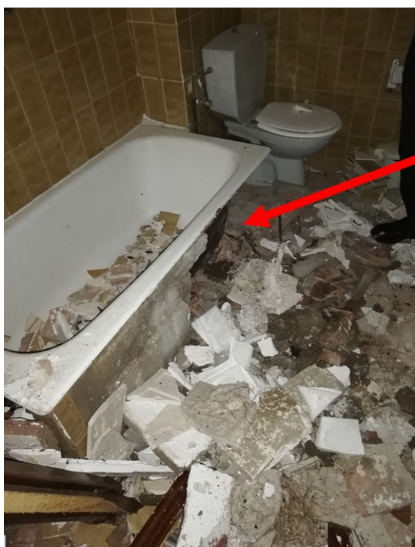
Figura 2: Estado de la bañera tras la deflagración
