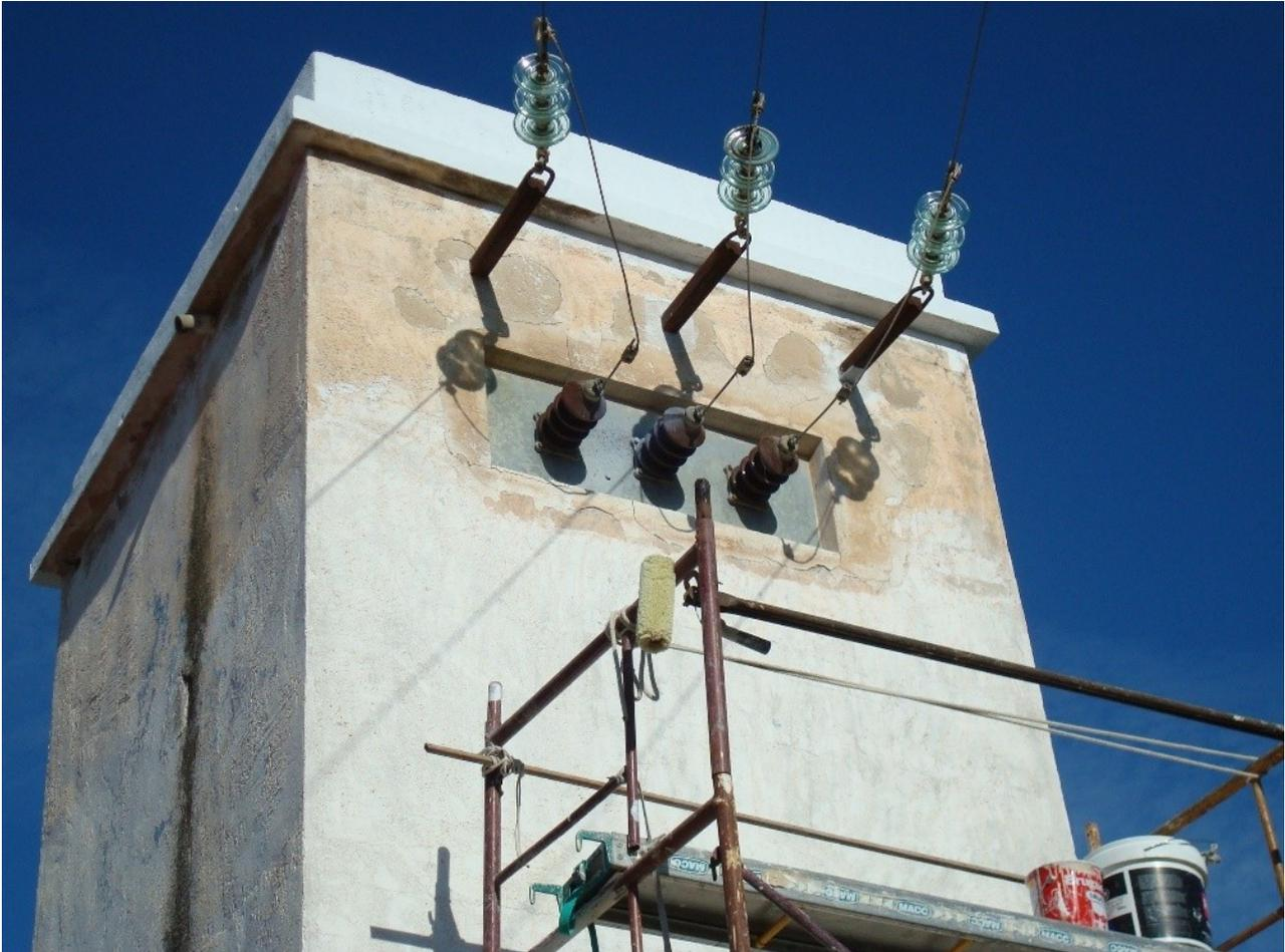
Figura 4- Detalle de por donde se encontraba pintando el trabajador cuando se produjo la descarga
