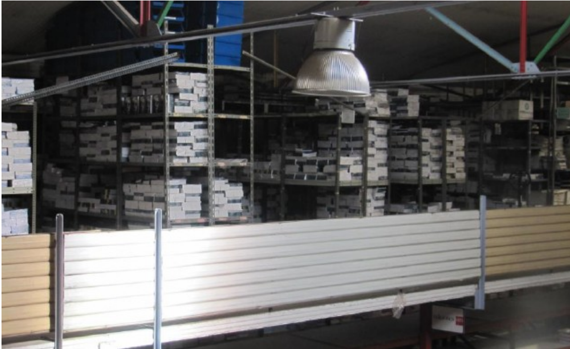
Altillo en el que se ha dispuesto una barandilla cuajada
