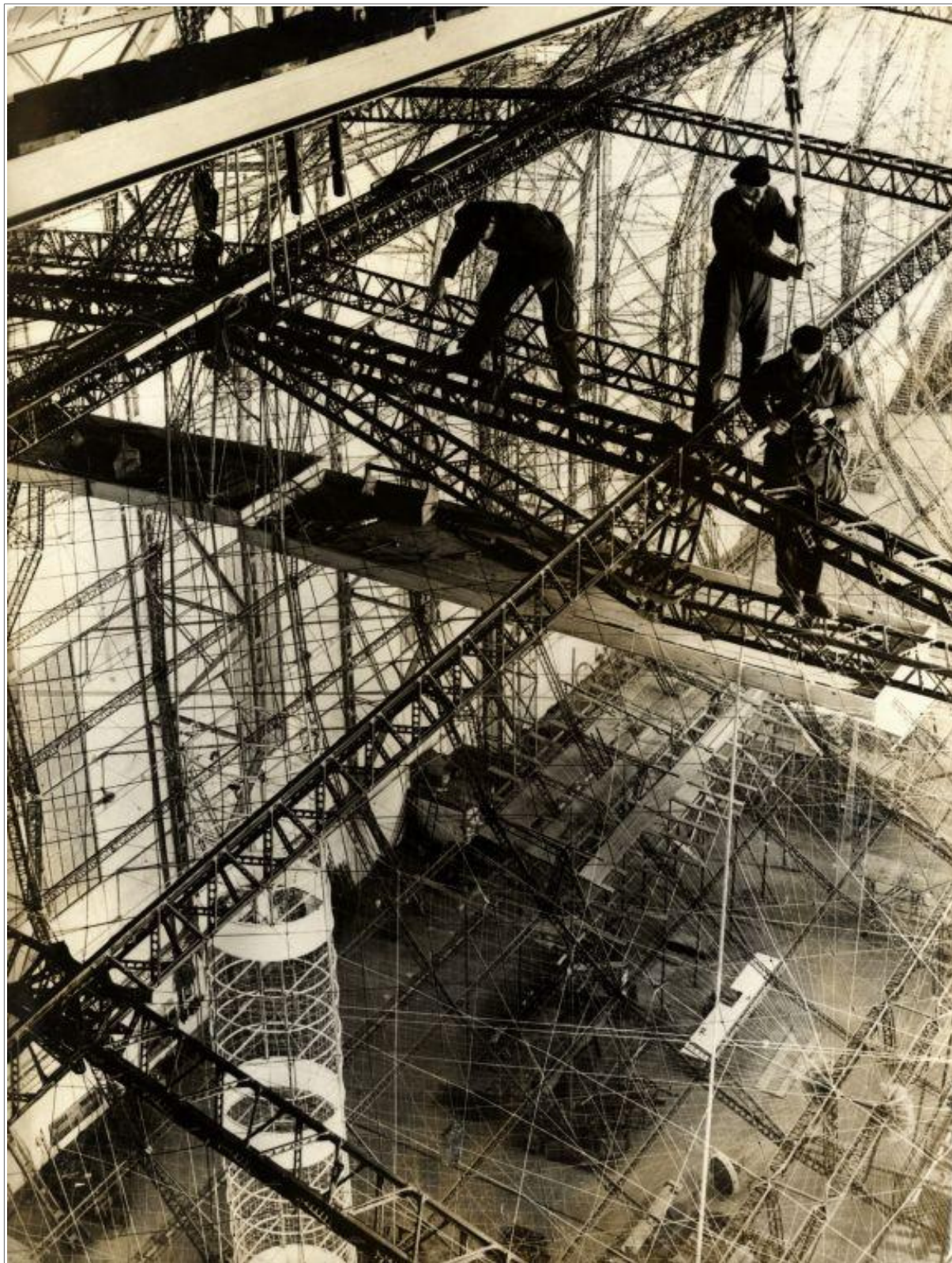
Trabajadores de la factoría Zeppelin, de Alemania, construyendo la estructura del dirigible LZ 129 Hindenburg. 1934. Nationaal Archief (Holanda), via flickr . Sin restricciones conocidas de derechos de autor
