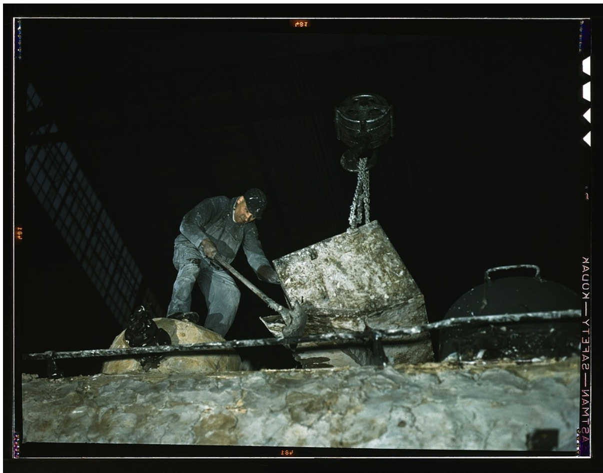
Jack Delano. Spreading asbestos mixture on boiler of a locomotive at the C & NW RR 40th Street locomotive shops. Trabajador del ferrocarril expandiendo una mezcla de amianto en la caldera de una locomotora. Chicago, Estados Unidos, 1942. Library of Congress . Sin restricciones conocidas de derechos de autor.
