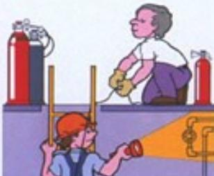
Entrada en las condiciones establecidas y con medios y equipos adecuados (ventilación suficiente, protecciones personales, escalera, cuerda de salvamento sujetada desde el exterior, etc.).
